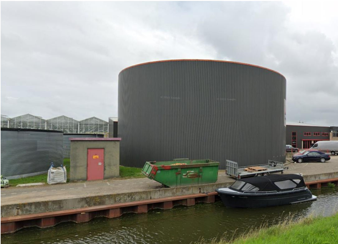
Figuur 8: Voorbeeld van een reservoir van circa 1360 m 3 , waarvan er bij het scenario 30 cm met maatregelen er circa 30.000 van nodig zijn om de extra watervraag van het veenweidegebied voor de maanden juni en juli van 2018 te overbruggen. (bron: Google Street View)
